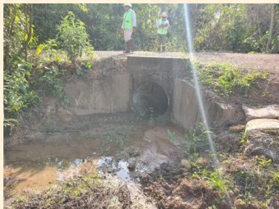
Alcantarillas en vías activas
